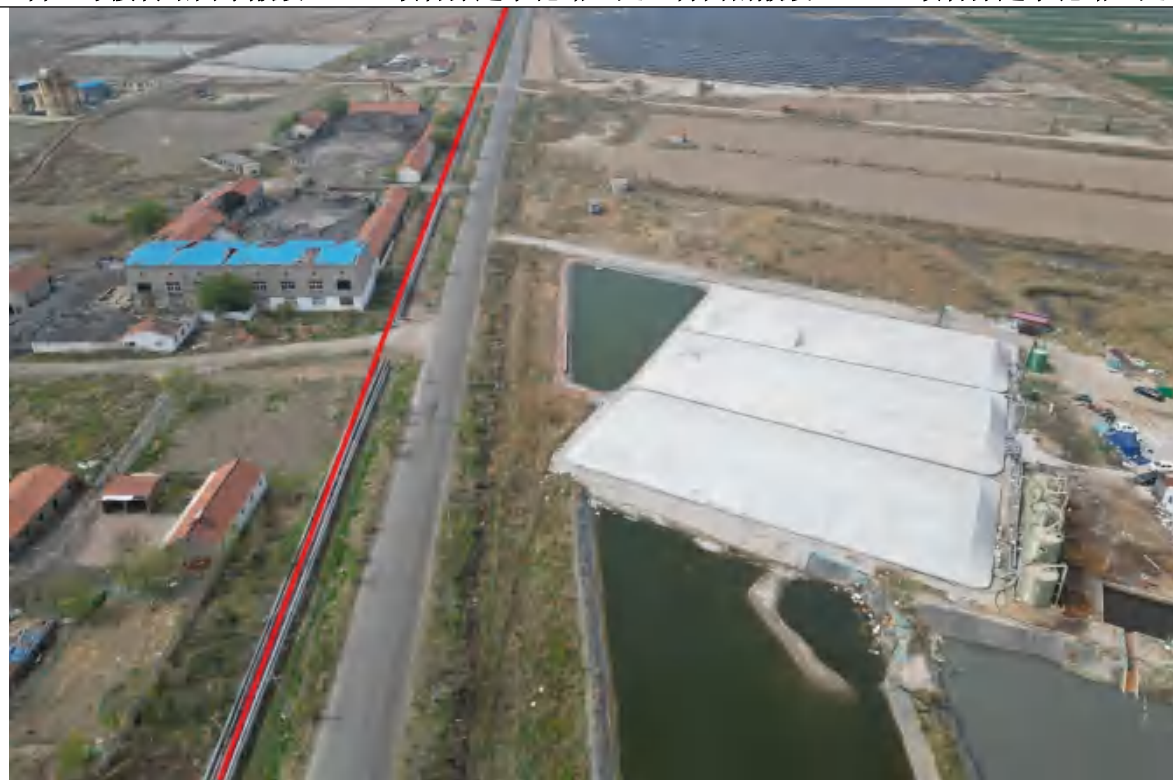
沿道路南侧向西南敷设1900m
