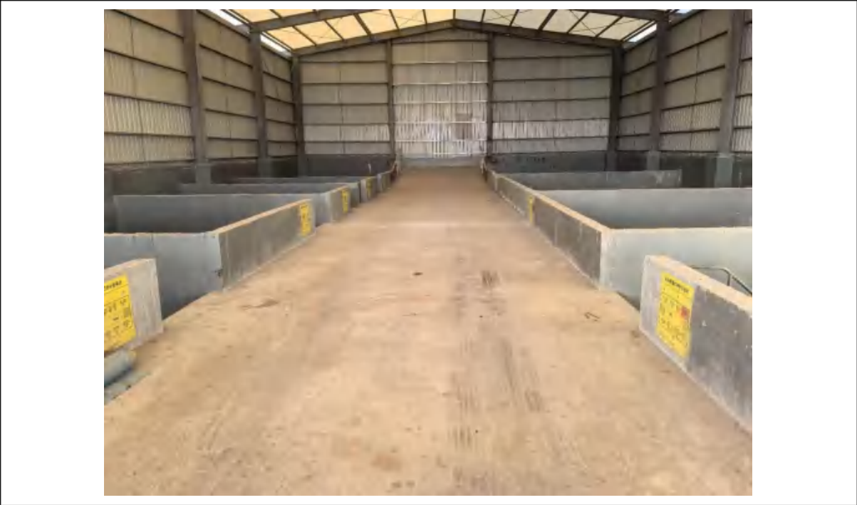
图 3.1-8 一号混输泵站危险废物贮存池现场照片
