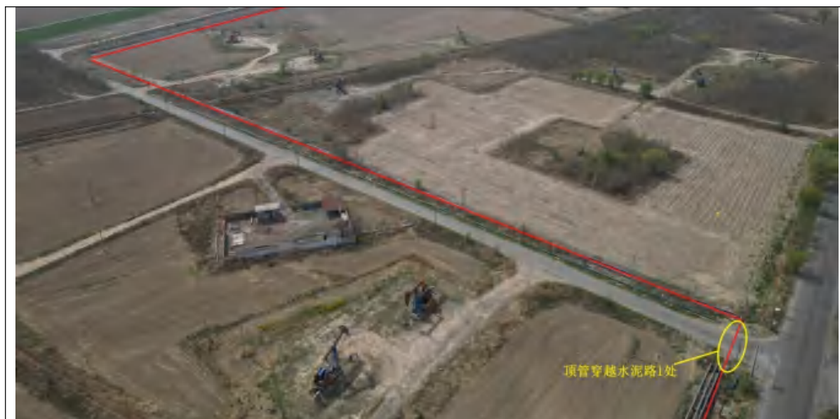
顶管穿越水泥路 1 处后，再沿道路西侧向东南敷设 350m
