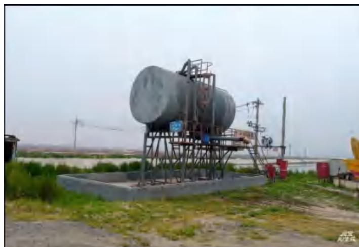
图 3.8-1 单拉罐围堰现场照片
