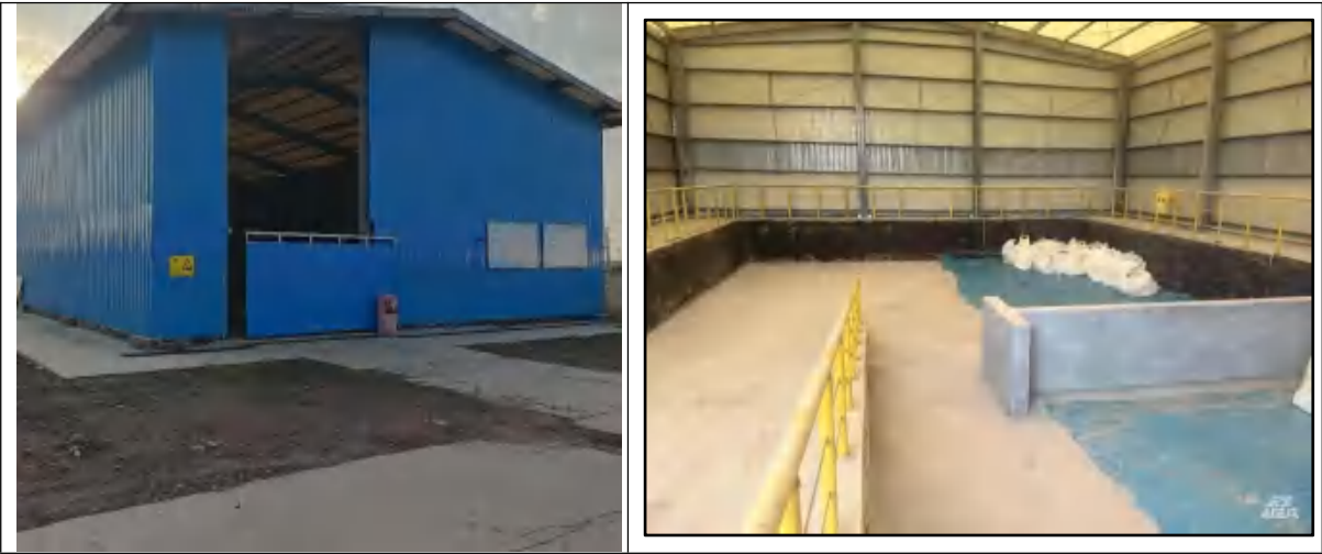
图 3.1-12 北块混输泵站危废贮存池现场照片
