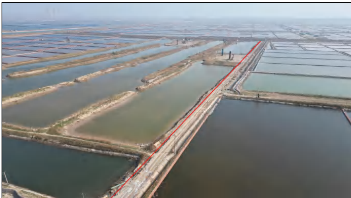
图 3.1-7 管线沿线生态现状照片
