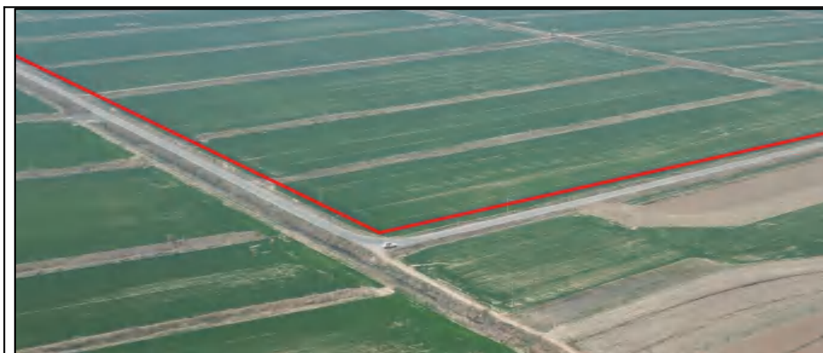
M120接转站外新建集油管线周边植被恢复情况
