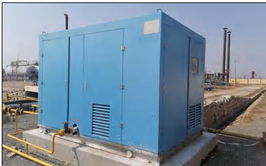
图 3.1-9 M120 接转站新建天然气压缩装置现场照片
